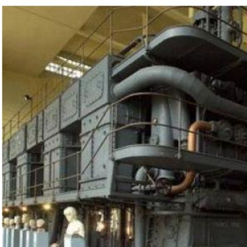
La Centrale Montemartini di via Ostiense
